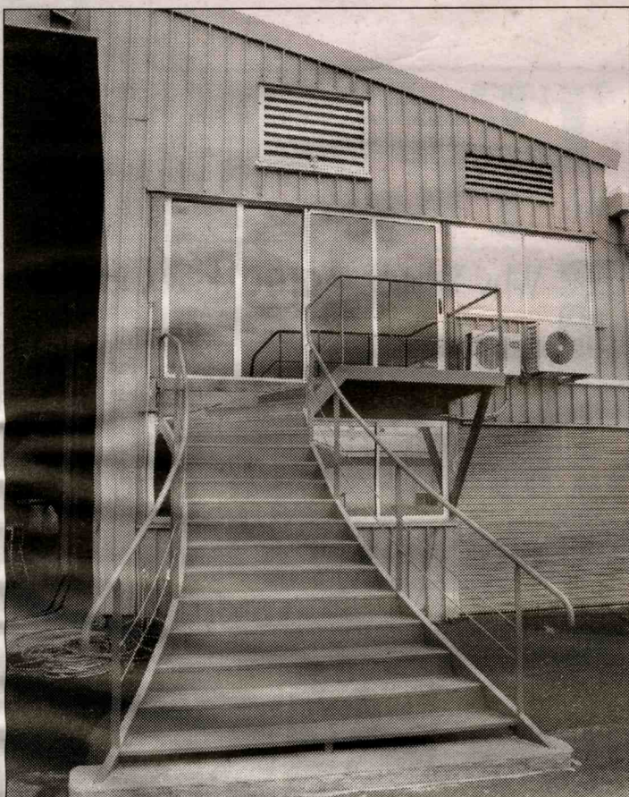
Un escalier d'accès a été spécialement installé dans le hangar de la zone nord pour accueillir passagers et équipages des jets privés.
